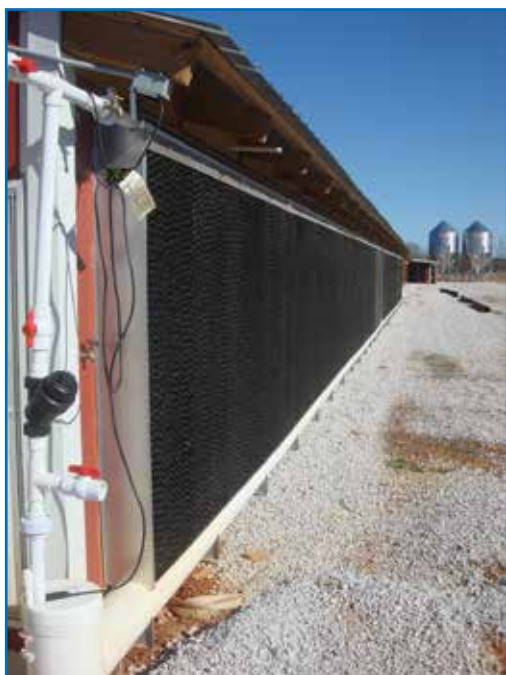
Рис. 45: Пример установки панелей охлаждения в боковых стенах птичника (в воздушном отсеке стены).
